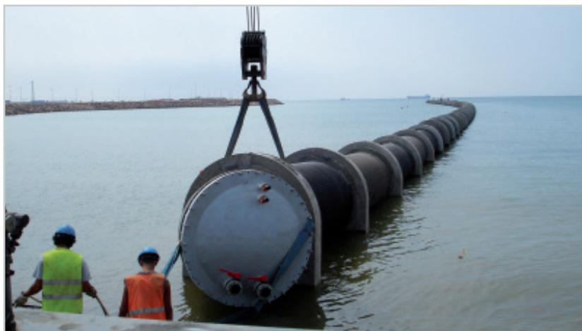
varo a mare tubi PE Spiralati DN 3000 mm con blocchi di affondamento in CLS
