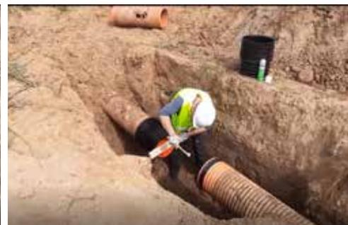
Insertar los tramos de tubería SN16 en cada extremo, conectándolos con la tubería existente mediante el manguito universal.
