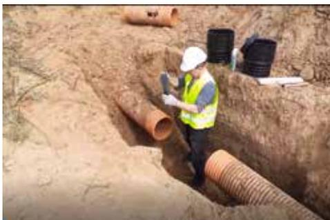
Cortar el tramo afectado, limpiar las extremidades y posicionar las juntas del fabricante del tubo a reparar.
