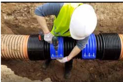
Posicionar los kits de abrazadera CorPress en ambos extremos e instalar la tornillería
