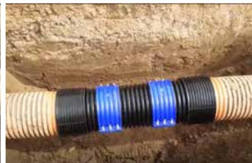
Sistema de reparación CorPress rápido, eficaz y con la máxima fiabilidad.
