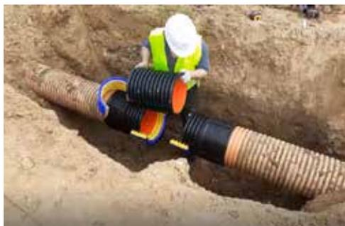
Insertar el tramo central de tubo MEGAPIPE SN16 con la longitud adecuada
