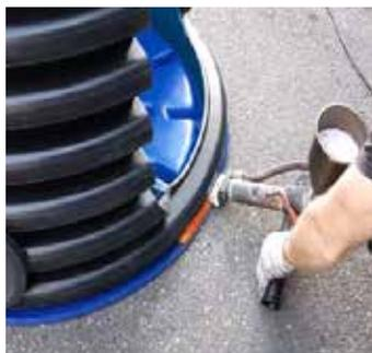
Fond soudé par extrusion avec ajout de matière (PEHD)
