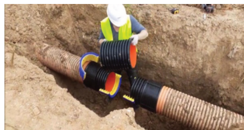
5. Posicionar los kits de abrazaderas CorPress en ambos extremos e instalar la tornillería
