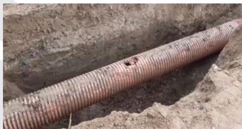
1. Liberar el tramo de tubería a reparar y el espacio de trabajo
