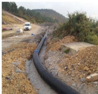
Obra en Navarra
