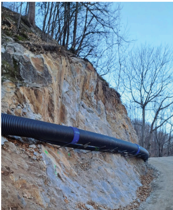
Obra en Morbegno (Italia)
