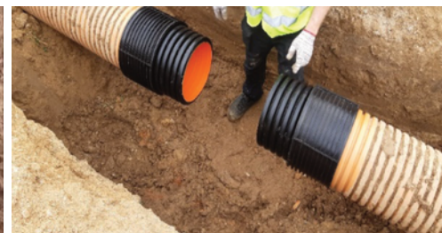
3. Conectar la tubería Megapipe en cada extremo de la tubería existente por medio de los manguitos Universales
