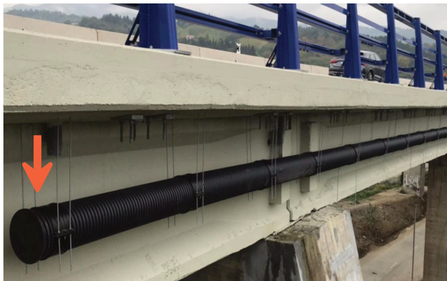
Viaducto Zarautz, Gipuzkoa
