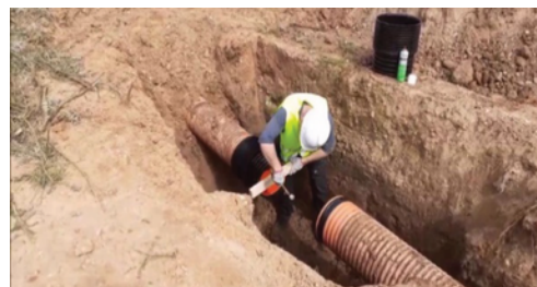
2. Cortar el tramo afectado, limpiar los extremos y colocar las juntas del fabricante del tubo a reparar
